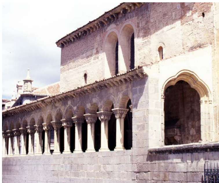
Galería porticada de la iglesia de San Martín de Segovia.
