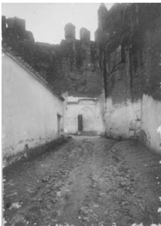
Fig. 5. La puerta del Socorro, ya cegada, y el nuevo acceso abierto en la muralla, tras el que aparece el antiguo templo parroquial de San Martín (fot. de hacia 1920 perteneciente a la colección de la Comisión Provincial de Monumentos de Huelva, Museo Provincial de Huelva).
